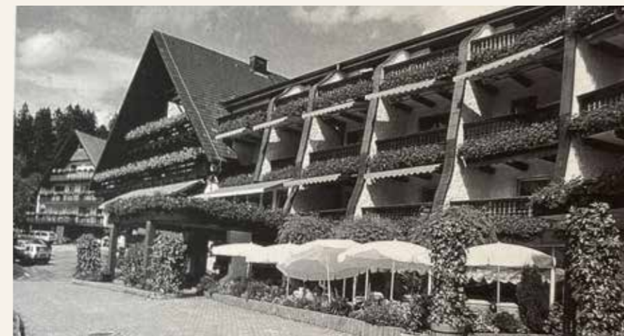
Au milieu des années 1990, les installations de bains du Dollenberg ont été raccordées directement à la source d'eau minérale.
