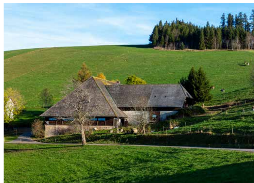
Le toit de la maison typique de la Forêt-Noire a été conçu en portant une attention particulière aux lourdes charges de neige en hiver et pour évacuer efficacement l'eau de pluie.
